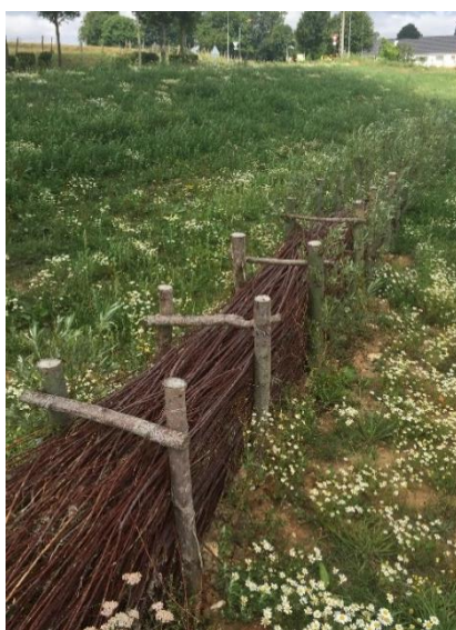
Implantation d'une fascine (à gauche) et d'une haie (à droite) par le SMBV pour ralentir les écoulements.
