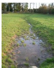
Figure 14 : Photo d'une noue enherbée
