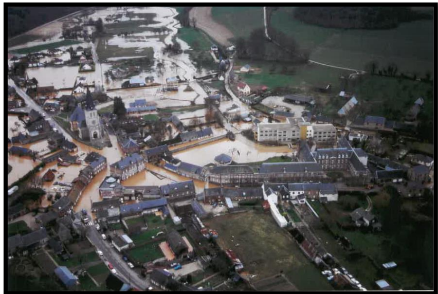
Figure 8. Photographie prise depuis un hélicoptère lors de l'inondation de 1995 du centre bourg de Grainville-La-Teinturière, nous pouvons observer sur cette photo l'église, à gauche, ainsi que la maison de retraite (bâtiment blanc, à droite) dans la zone inondable (crédit : M. Barry).
