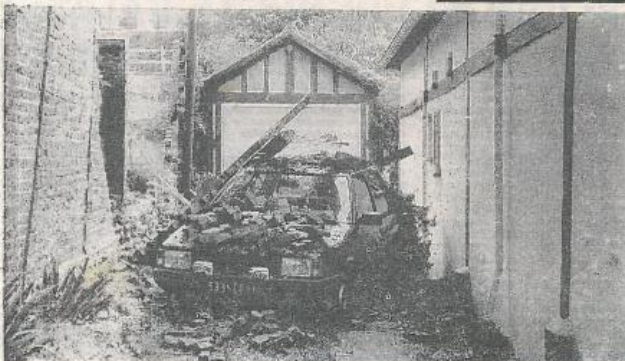
Aux Petites-Dalles, un mur s'est effondré, blessant une personne et endommageant deux voitures
