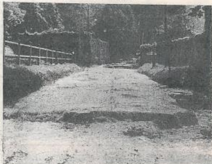
A Veulettes, au fond de la vallée, un mur a été emporté dans la rue transformée en rivière
