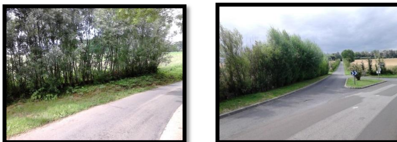
Figure 17: Photographies de fascines diagnostiquées destinées à bloquer les sédiments pour protéger la voirie
