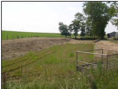
Figure 5 : Bassin de rétention (Source : Cyril LAMARRE)
