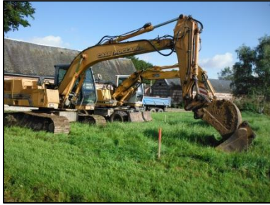
Figure 26 : Mise en place du marquage (source : Cyril LAMARRE)
