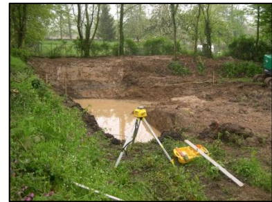
Figure 27 : Réajustement de l'implantation durant un suivi de chantier (source : Cyril LAMARRE)
