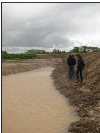
Figure 28 : Réception d'un chantier (source : Cyril LAMARRE)
