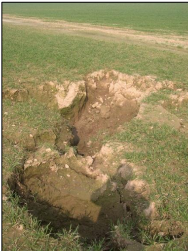
Figure 2 : Bétoire (source : Cyril LAMARRE)
